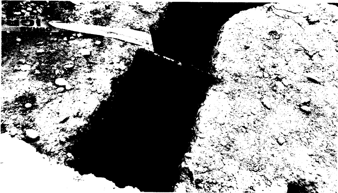
EJECUCION DE TRABAJOS DE EXCAVACION DE ZANJAS PARA CIMENTACION GARITA DE CONTROL
