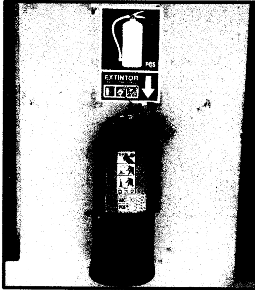
Foto N° 09: Extintor operativo e inspeccionado con su señalética correspondiente.
