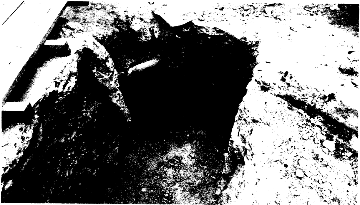
EJECUCION DE TRABAJOS DE EXCAVACION DE ZANJAS PARA CIMENTACION COLUMNA C6
