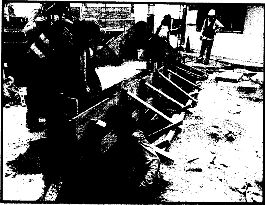
Fotografía N° 09: Vaciado de sobrecimiento.
