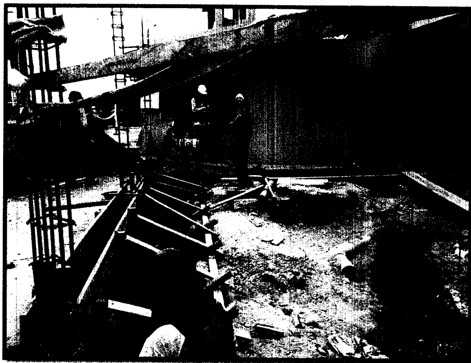
Fotografía N° 08: Encofrado de sobrecimiento.
